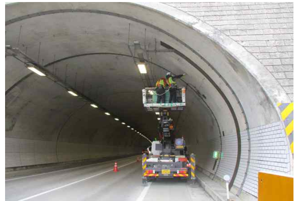
고소작업차를 이용한 외관조사 현황①
