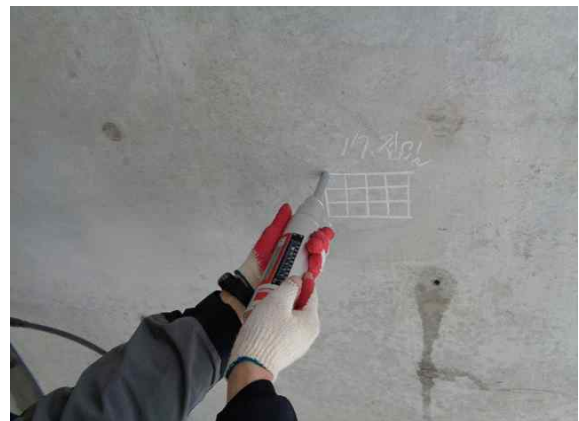
반발경도 측정 현황(측벽부)
