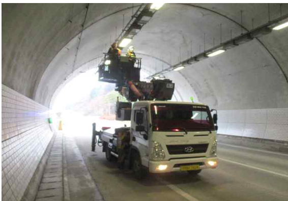
고소작업차를 이용한 외관조사 현황②
