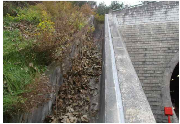
중점부 도수로 전경
