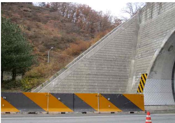
시점부 옹벽 전경
