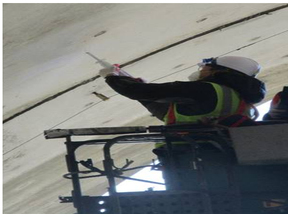
반발경도 측정 현황(천단부)
