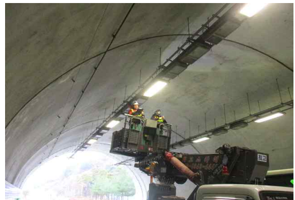
고소작업차를 이용한 외관조사 현황③
