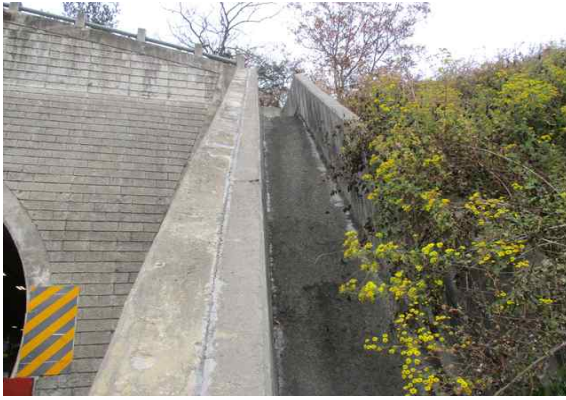
시점부 도수로 전경
